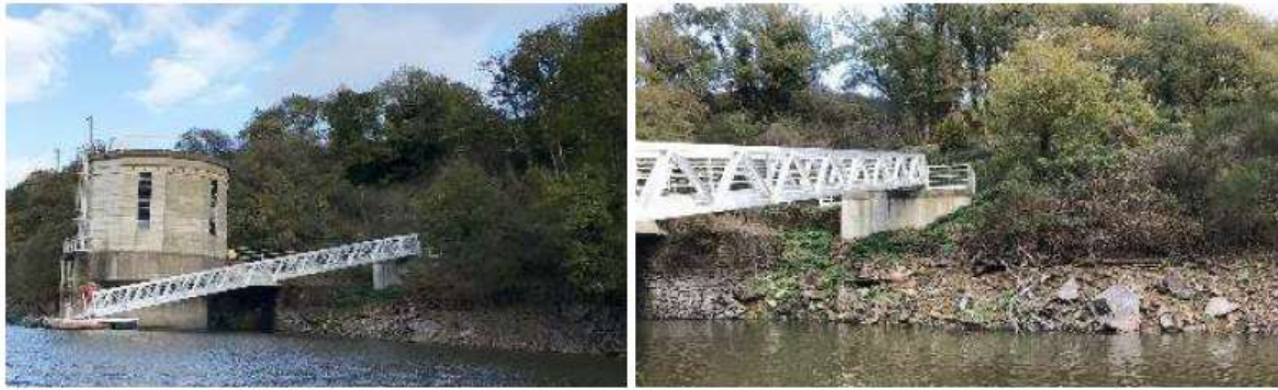
Figure 15 : Passerelle et ponton près de la tour d'exhaure, depuis la retenue et détail de la ripisylve (IDRA)
